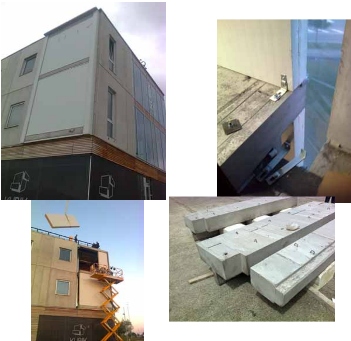
Figura 1. Ejecución de la fachada de calibración y de las tres vigas que simulan los frentes de forjado de los edificios de estructura de hormigón en Junio de 2011.
