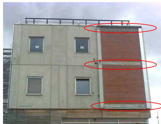
Figura 30. Frentes de forjado en un edificio tipo de fábrica de ladrillo caravista y la fachada oeste de kubik con los frentes de forjado ejecutados.
