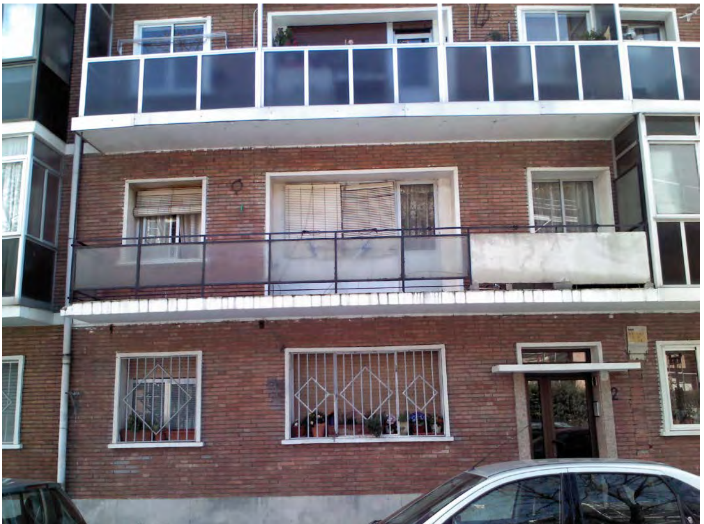
Bloque de Zaramaga, estado actual de la fachada oeste
