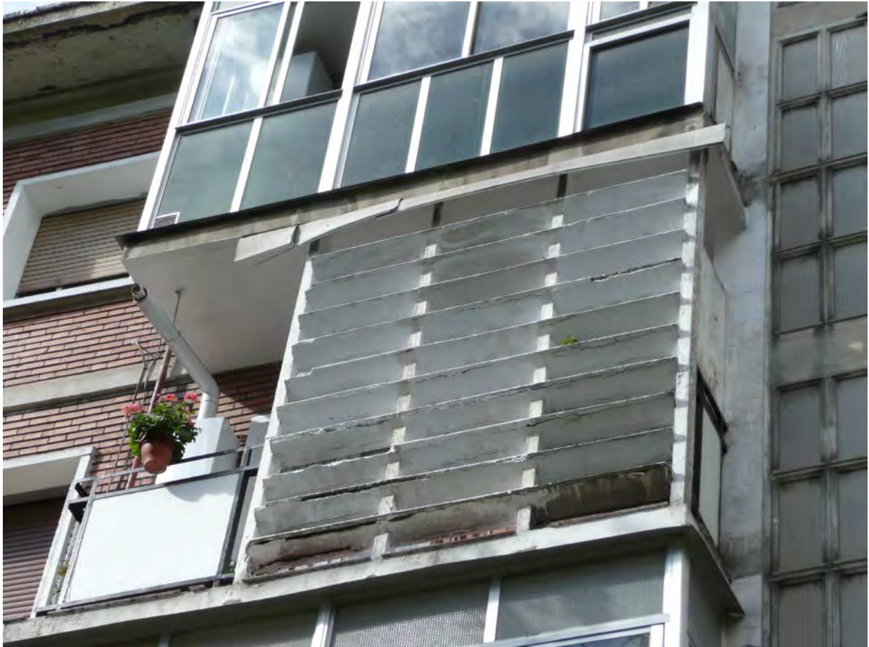
Bloque de Zaramaga, balcón y celosía originales.
