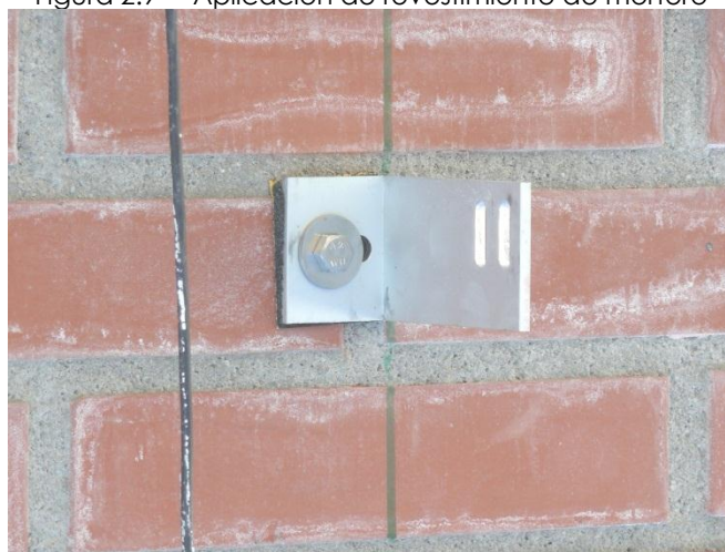
Figura 2.10 – Anclaje atornillado sobre el ladrillo caravista
