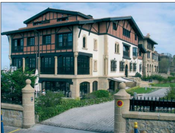
Hotel Embarcadero, Getxo, Bizkaia. Obra del 2002: Aislamiento térmico
