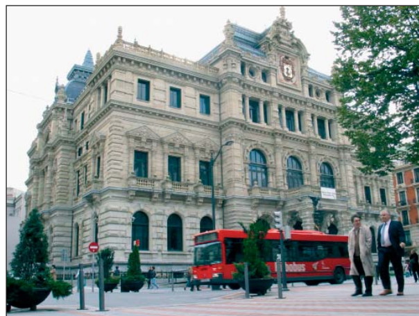
Diputación Foral de Bizkaia, Bilbao. Bizkaia. Obra del 2002: Sistemas constructivos a base de cartón-yeso
