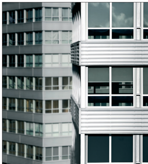
Torres de Salburua, Vitoria-Gasteiz. Álava-Araba. Promoción y construcción de 4 torres bioclimáticas. 118 viviendas, 183 garajes, 4035 m 2 oficinas y 900 m 2 locales
