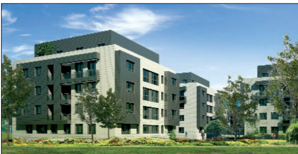
Mirador de Fátima, Enekuri. Bizkaia. Promoción y construcción de 77 viviendas libres y 25 de protección oficial y 196 garajes
