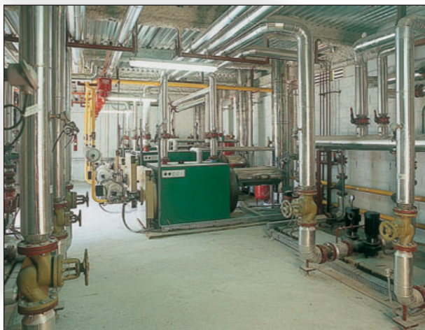
Centro Comercial el Mirador. Burgos
