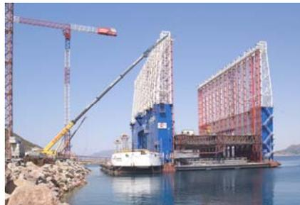
Cajonero para construcción de estructuras flotantes de hormigón. Permite trabajos en costa o alta mar y traslado de componentes.
