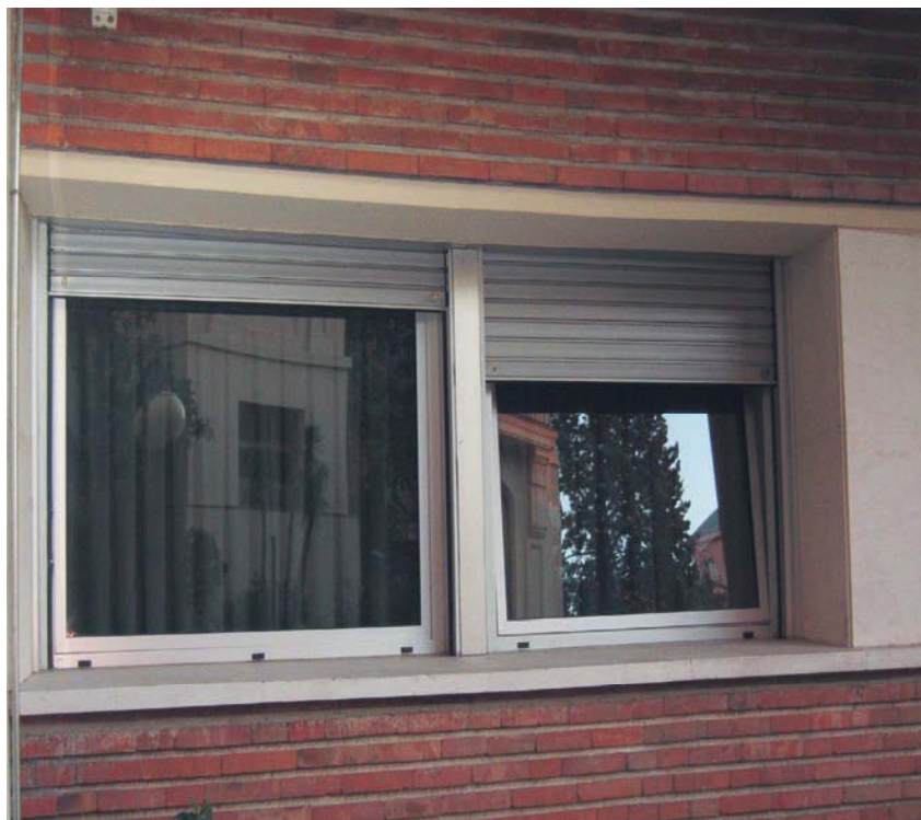
Foto 17. Carpintería metálica de aluminio RPT con doble acristalamiento banal.
