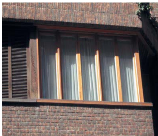
Foto 19. Carpintería de madera con doble acristalamiento banal.
