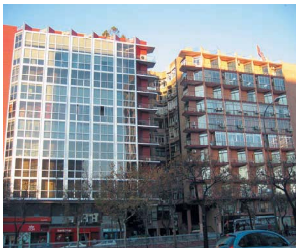
Foto 1. Rehabilitación total de huecos de fachada y situación inicial.
