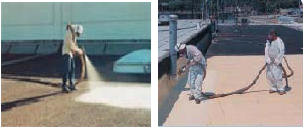
Foto 3. Rehabilitación de la cubierta con proyección de espuma de poliuretano.
