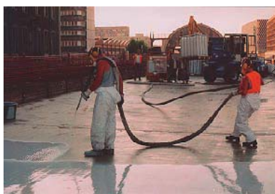
Foto 5. Membranas de secado por reacción química de aplicación in situ .
