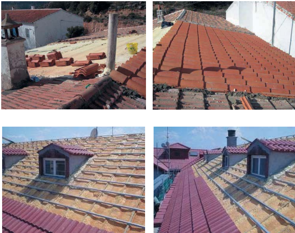
Foto 6. Renovación del tejado.
