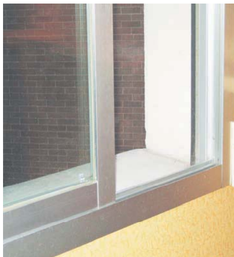
Foto 14. Carpintería metálica de aluminio con doble acristalamiento banal.
