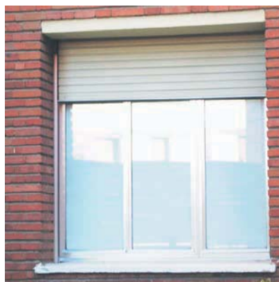
Foto 13. Carpintería metálica de aluminio con vidrio monolítico.
