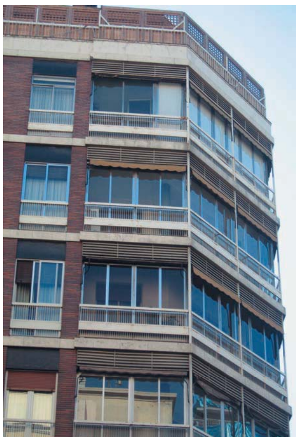
Foto 2. Rehabilitación de huecos de fachada.
