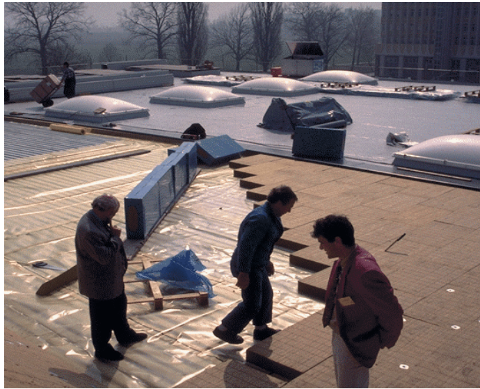
Foto 2. Cubiertas con fijación mecánica.
