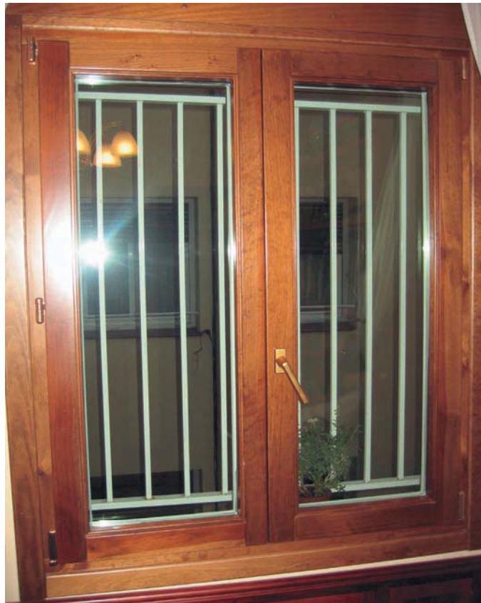
Foto 20. Carpintería de madera con doble acristamiento bajo emisivo. SGG CLIMALIT con SGG PLANISTAR.
