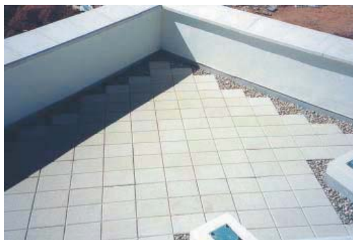
Foto 2. Cubierta invertida transitable.
