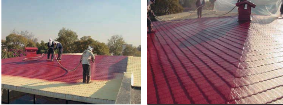
Foto 5. Rehabilitación de la cubierta con proyección de espuma de poliuretano sobre teja o pizarra y proyección con elastómero.
