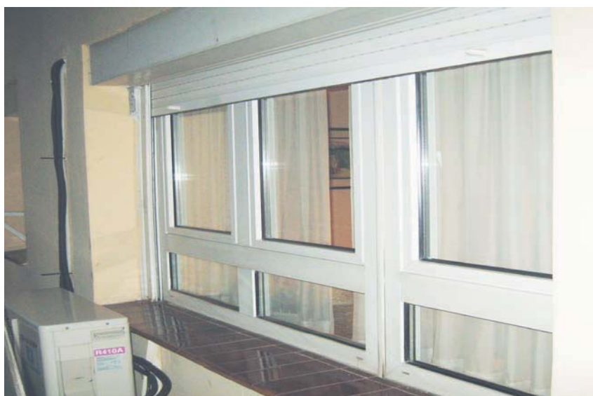
Foto 22. Carpintería PVC con doble acristalamiento bajo emisivo.
