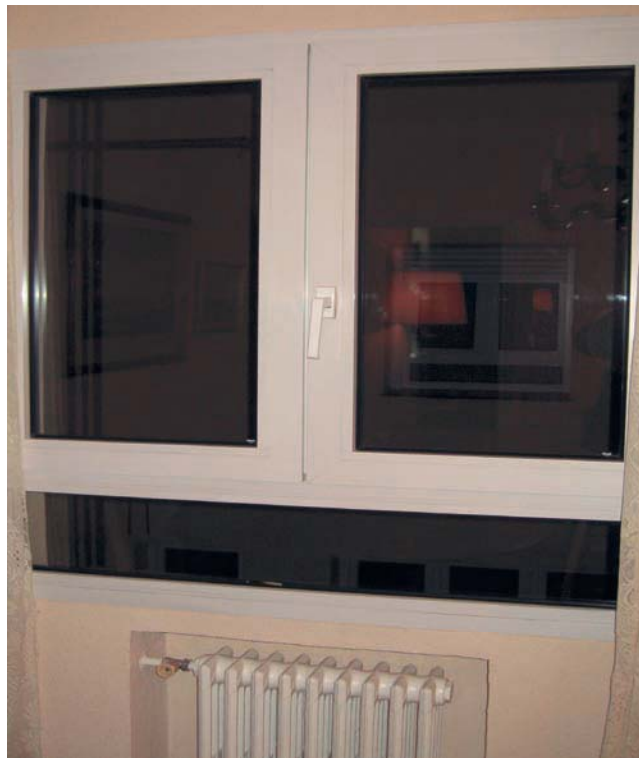
Foto 21. Carpintería PVC con doble acristalamiento banal.
