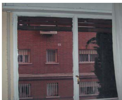
Foto 12. Carpintería metálica “acero Mondragón” con vidrio monolítico.
