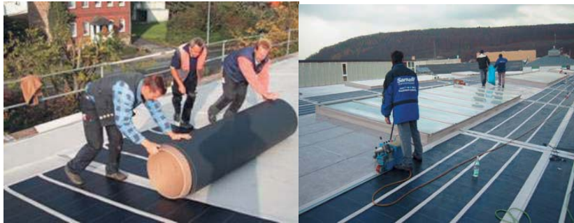
Figura 7. Montaje de los módulos-PV.
