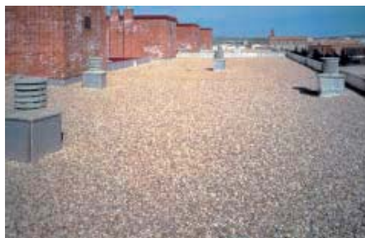
Foto 1. Cubierta invertida no transitable.
