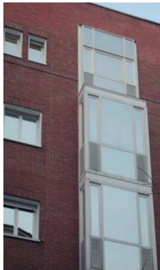
Foto 8. Cerramientos orientados al Este acristalados con vidrio de control solar.
