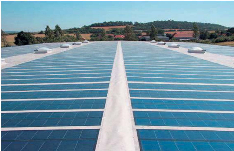
Foto 1. Cubierta solar terminada.
