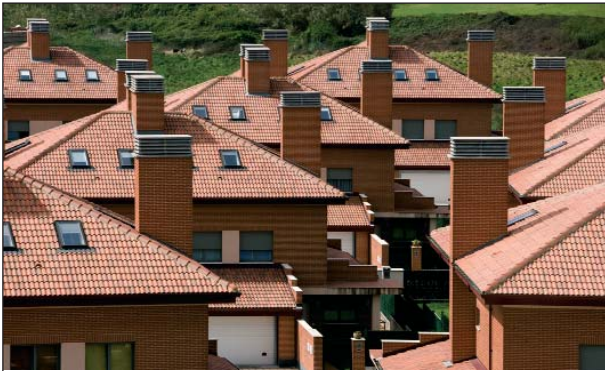
Erandio. Bizkaia. 98 babes ofizialeko txaleten eta 93 txalet libreren sustapena eta eraikuntza
