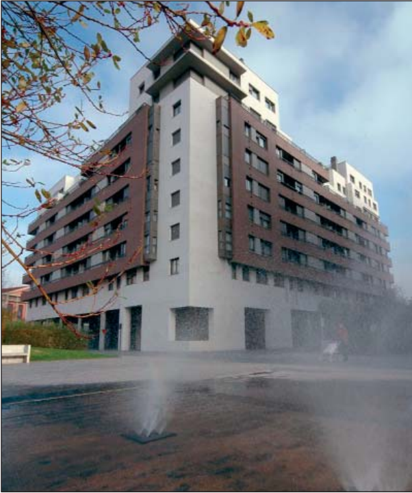
Residencial Parque Europa etxebizitzak, Desierto enparantza, Barakaldo. Bizkaia. 2000tik 2002ra egindako obra: iragazgaiztea eta isolamendu termikoa
