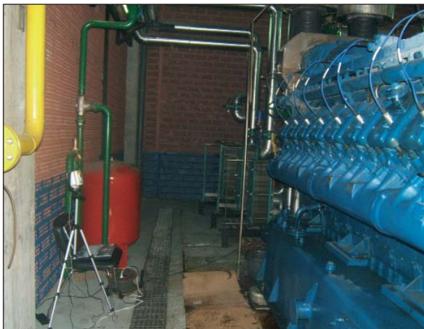
Cogeneración Bergara AlEren Deutz TCG2020V20 motorreko pistoiaren ikuskapena, kamera termografiko bidez.
