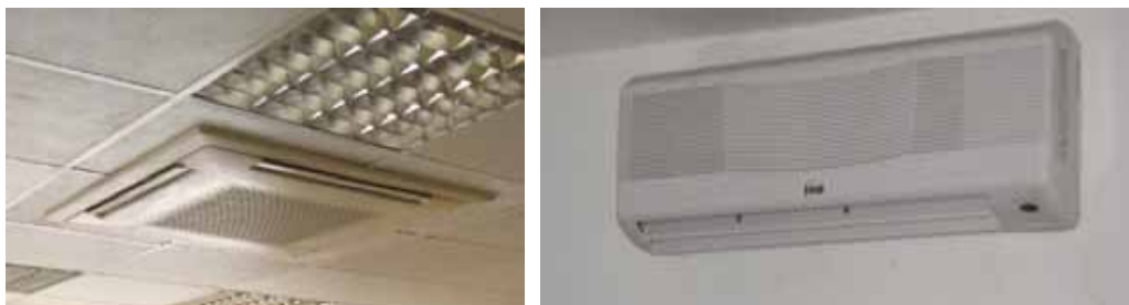
Foto A2.12. Distintos equipos tipo Split (tipo cassette y de pared, respectivamente).
