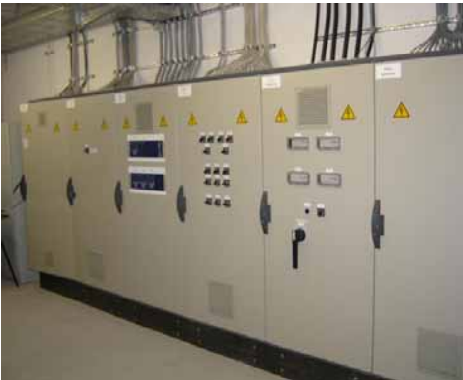
Foto A1.4. Unidad central de energía geotérmica Geozent® Prof. (Fuente: Zent Frenger).
