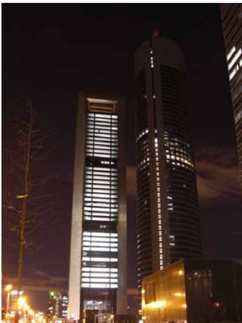
Foto A3.1. Iluminación exterior de edificios de oficinas en el complejo CTBA de Madrid.
