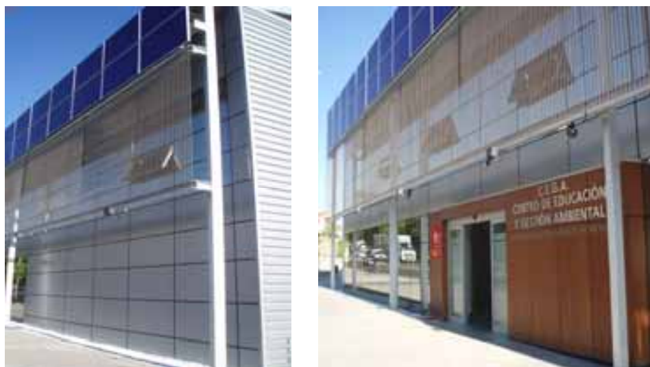
Foto A1.11. Paneles fotovoltaicos instalados en las oficinas del Centro de Educación y Gestión Ambiental de San Sebastián de los Reyes.
