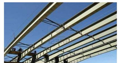
En esta tipología se podrían incluir las vigas armadas (perfiles soldados) se fabrican a partir de chapa de acero estructural. Pueden tener alas de dimensiones diferentes, formando una sección mono-simétrica. Estos perfiles ofrecen la posibilidad de diseñar elementos cónicos, lo cual sirve para optimizar la cantidad de material, con un interesante efecto arquitectónico. Esta solución se utiliza, normalmente, para vigas de mayor tamaño que los perfiles laminados estándar
