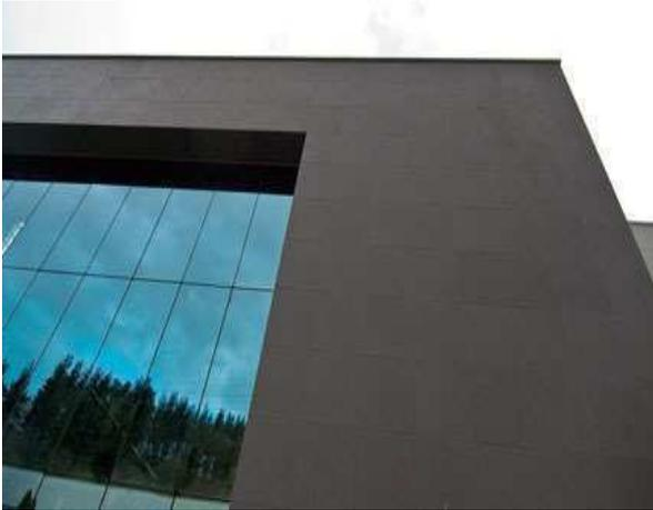
Los Cerramientos ULMA son sistemas de cerramiento autoportante multicapa que resuelven la envolvente completa/integral con el aislamiento acústico y térmico requerido en cada caso. Se trata de sistemas constructivos ligeros (92 kl m<sup>2</sup> con Hormigón Polímero), que se montan en seco y permiten la colocación de diferentes pieles exteriores de acabado.
