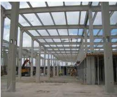
El sistema está fundamentado en una producción con mentalidad industrial a base de elementos lineales o barras (vigas y soportes), superficiales (placas, paneles), de componentes básicos prefabricados de hormigón, para la realización de estructuras y cerramientos, fundamentalmente destinado al ámbito industrial, y el panel arquitectónico para el residencial, dotacional, etc
