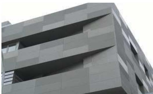
La fachada ventilada es un sistema de revestimiento de los paramentos del edificio que deja una cámara ventilada entre el revestimiento y el aislamiento. En círculos académicos europeos, es considerado como el sistema más eficaz para solucionar el aislamiento del edificio, eliminando los indeseables puentes térmicos así como los problemas de condensación y obteniendo de este modo un excelente comportamiento térmico-higrométrico del edificio.
