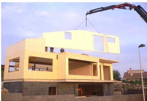
El sistema se basa casi fundamentalmente en los tableros EGO\_CLT™ y EGO\_CLT MIX™, elaborados en sus distintas versiones, fundamentalmente relativas a aspectos dimensionales, espesores y de composición, así como en los acabados finales de terminación superficial.
