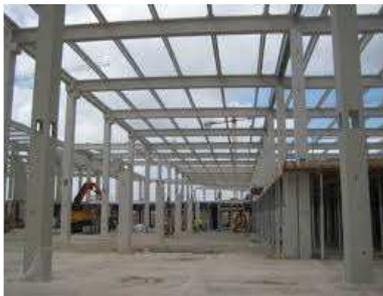
El sistema está fundamentado en una producción con mentalidad industrial a base de elementos lineales o barras (vigas y soportes), superficiales (placas, paneles), de componentes básicos prefabricados de hormigón, para la realización de estructuras y cerramientos, fundamentalmente destinado al ámbito industrial.
