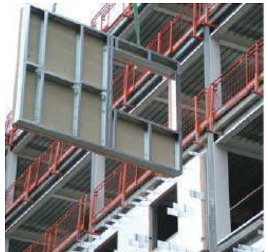
Los elementos-paneles prefabricados en taller, pueden tener el grado de acabados, relativos a otros subsistemas, protección, aislamiento, revestimientos, carpintería, instalaciones, etc, tan complejos y en la multitud de opciones que se puedan dar en el diseño.
