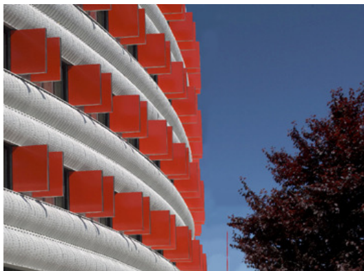
VIVIENDAS EN NDAIN
